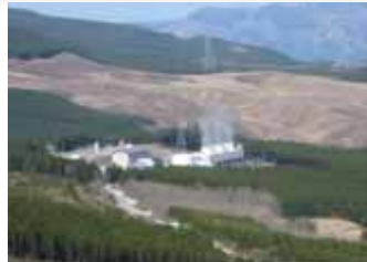
滝上発電所 蒸気供給：出光大分地熱（株） 発電：九州電力（株）
