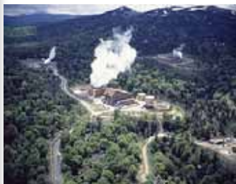
澄川地熱発電所 蒸気供給：三菱マテリアル（株） 発電：東北電力（株）
