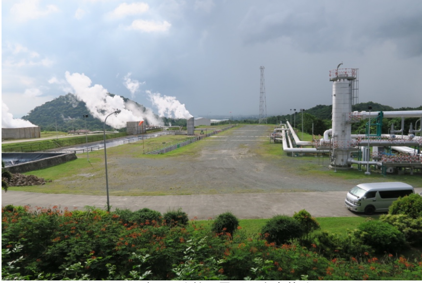
マイバララ地熱発電所の生産基地
